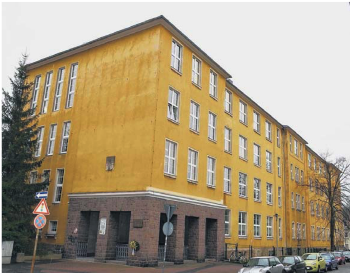
Heute befinden sich in dem markanten Gebäude an der Bergstiftsgasse 1 das Freiberg Kolleg und die Berufsbildende Förderschule.
